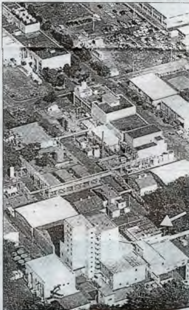
Ураноперерабатывающий комплекс, на котором произошла авария (стрелкой указано здание, где произошла СЦР)
