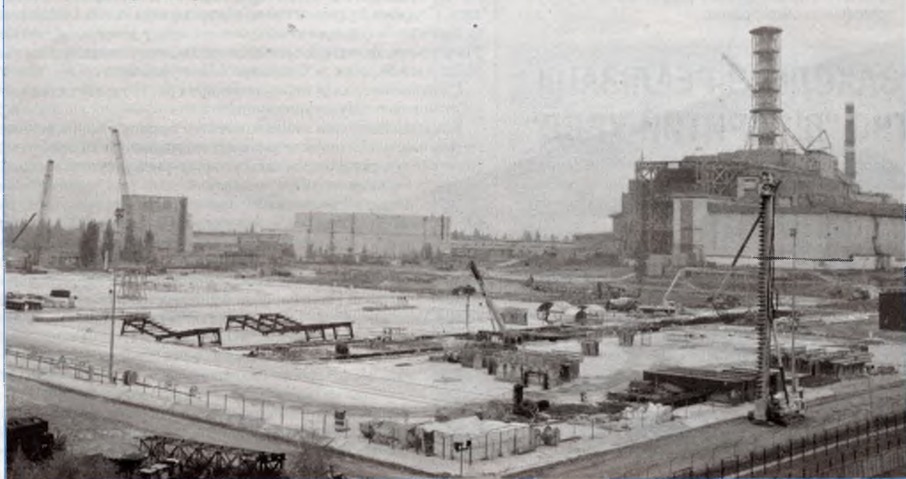
Майданчик будівництва НБК
