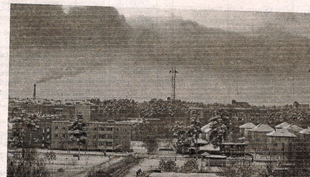
Реконструкція димової труби центральної котельні міста
