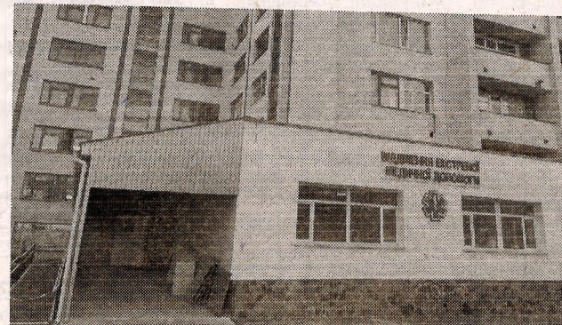
Капітальний ремонт приймального відділення та відділення екстреної медичної допомоги
