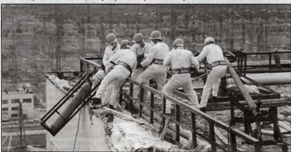
Ремонтні роботи на маківці «саркофага». Бєри наші і... проблеми теж
