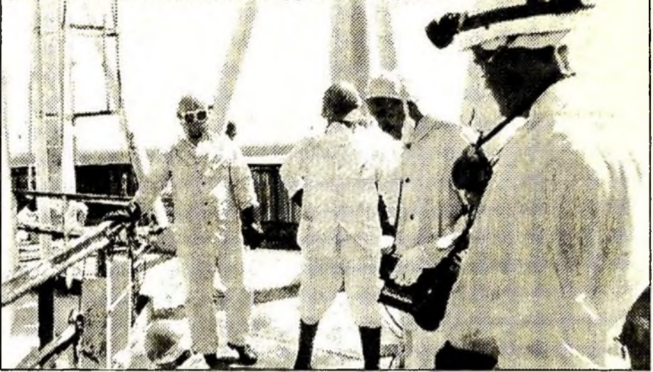
Подготовка к дезактивационным работам на второй площадке вентиляционной трубы "саркофага".
