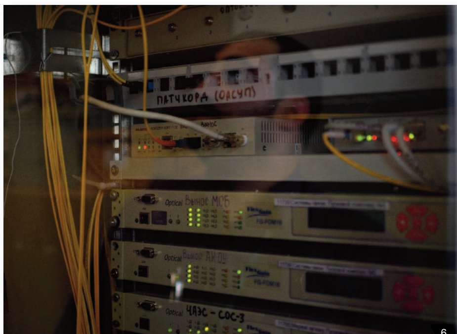
Сучасне обладнання, що розподіляє телефонні дзвінки до різних об'єктів на майданчику Чорнобильської АЕС.
