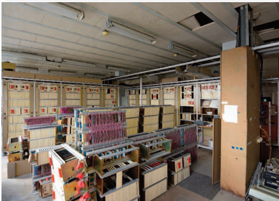
Застаріла АТС «КВАНТ», яка не використовується з 2007 року. Ця система шаф, плат та дротів займає майже половину крила одного з поверхів будівлі КВАНТ. Після модернізації системи телефонії функцію однієї шафи АТС КВАНТ виконує плата розміром 30 на 30 сантиметрів.
