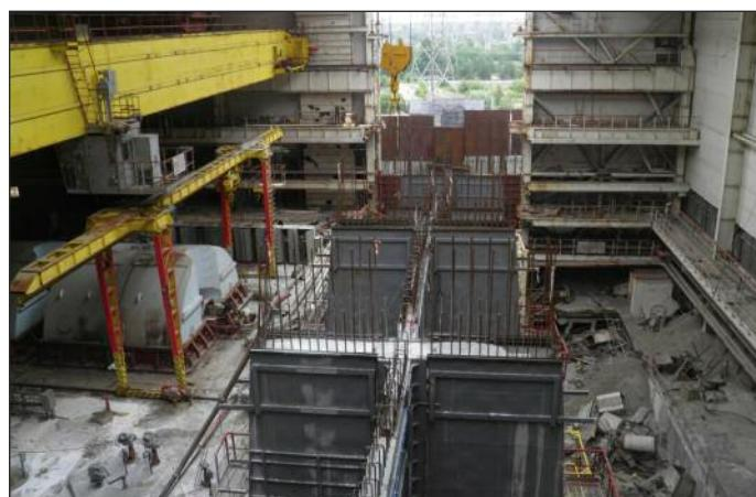
Виконання проекту забезпечило створення необхідних будівельних конструкцій, а також реконструкцію усіх наявних систем захисного контуру та систем контролю об'єкта «Укриття»,
