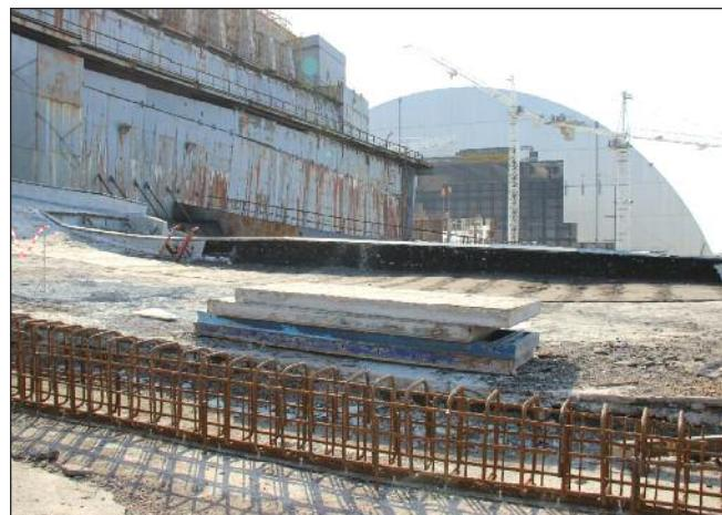
зокрема систем вентиляції, пожежогасіння та низки інших. Для зведення стін захисного контуру НБК у межах машинного залу 4 блока ЧАЕС виконано демонтаж понад 1800 м<sup>3</sup> залізобетонних конструкцій, недіючих трубопроводів і технологічного обладнання, що залишилися після аварії 1986 року, демонтовано 600 м<sup>2</sup> покрівель, укладено 14000 м<sup>3</sup> бетону і 1450 тон арматури.
