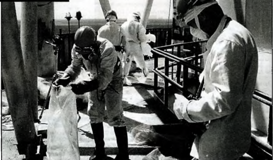
Дезактиваційні роботи на об'єкті «Укриття» тривають...
