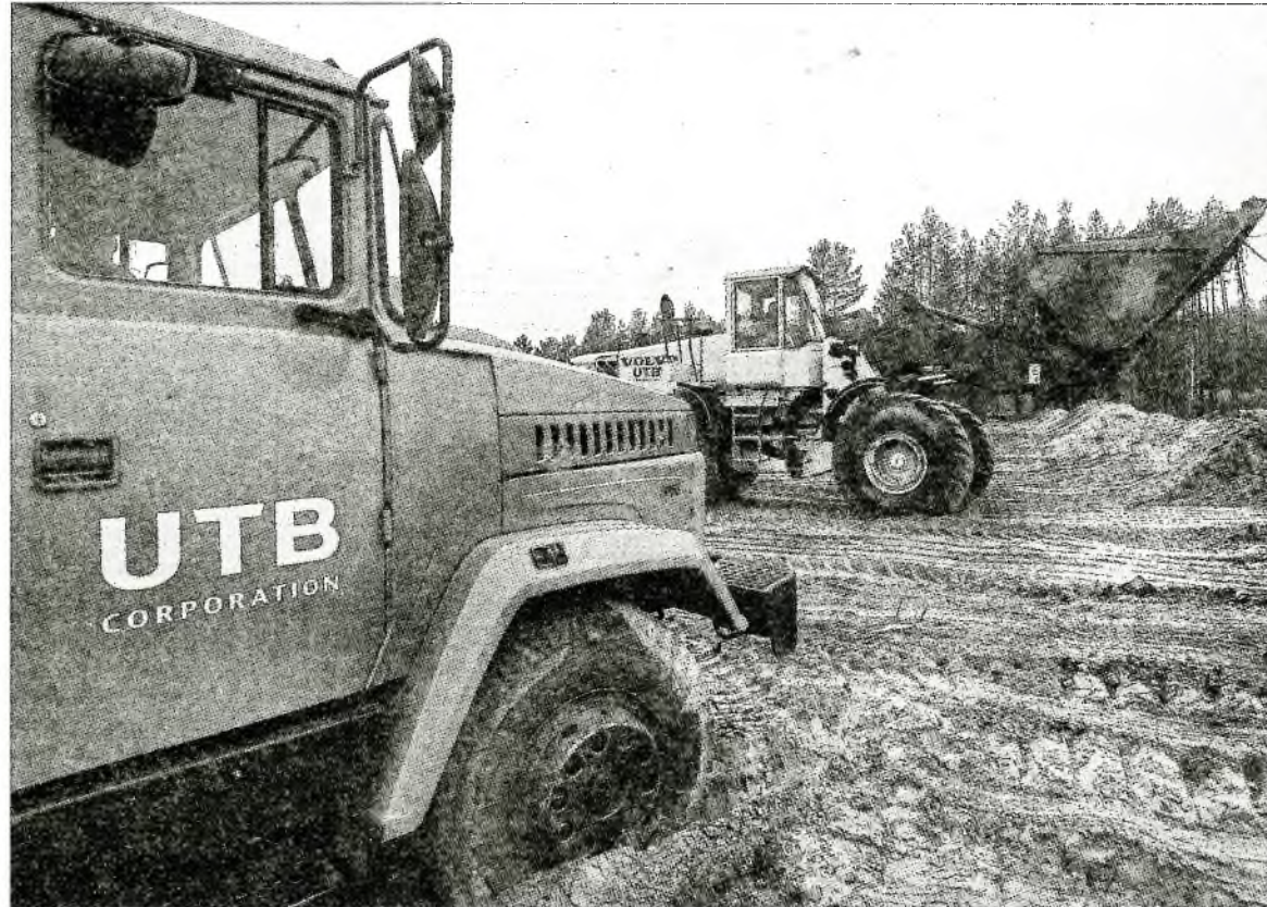
Будівництво Централізованого сховища відпрацьованого ядерного палива нарешті розпочалося. Здати в експлуатацію обіцяють 2019 року
