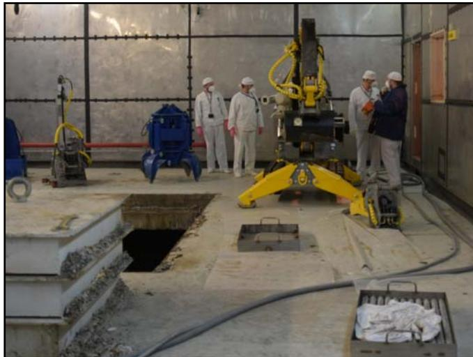
Для проведения работ по характеризации ТРО были раскрыты восточный и западный «легкие» отсеки хранилища твердых РАО и отобраны пробы. Идет процесс лабораторных исследований отобранных проб на выявление радионуклидного состава и удельной активности радионуклидов.
