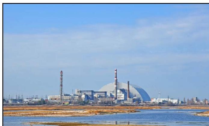
Продолжался радиационно-экологический мониторинг снятия с эксплуатации водоема-охладителя в соответствии с ТЭО. Уровень воды в водоеме-охладителе понизился на 5,5 м. Осушено 42% площади зеркала.
