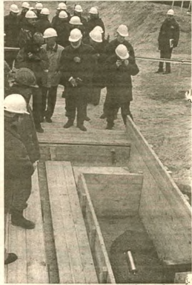
Момент закладки капсулы и первого кубометра бетона на строительстве промышленного комплекса по обращению с твердыми радиоактивными отходами
