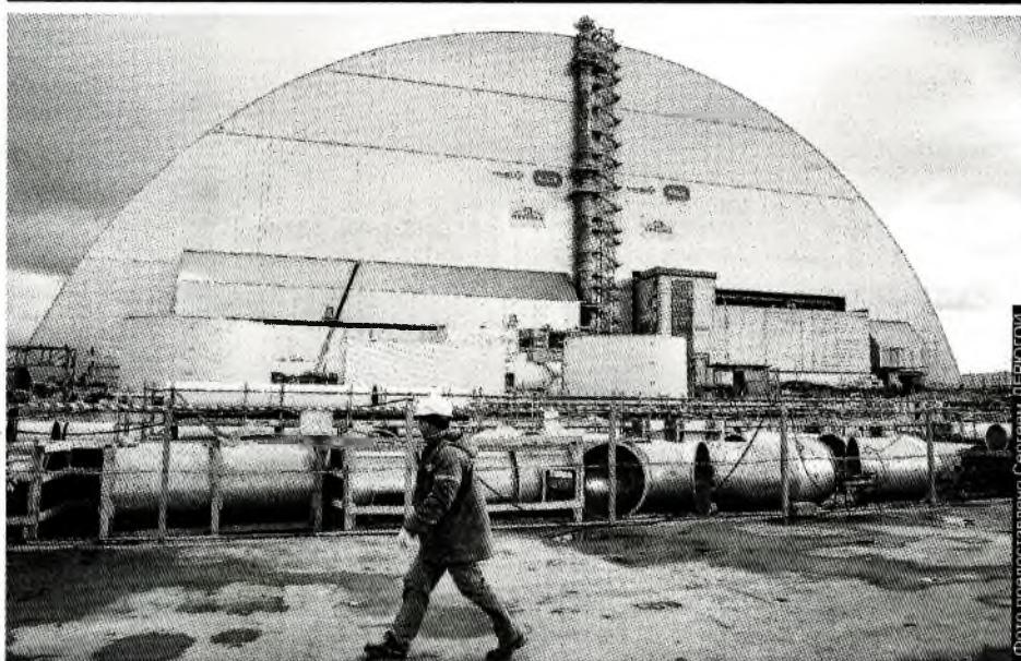
«Арка» сделана из двух слоев нержавеющей стали. Внутри этой конструкции будет поддерживаться пониженное давление, чтобы воздух с радиоактивной пылью не выходил наружу
