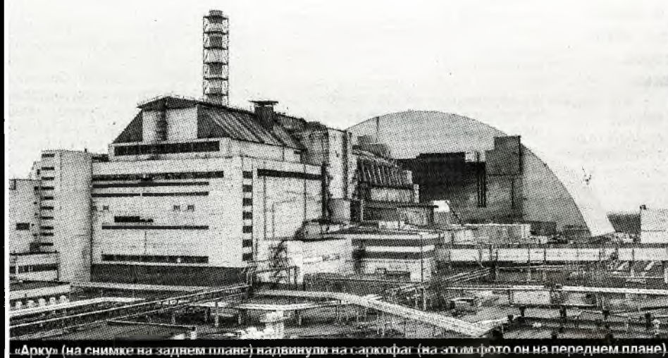
«Арку» (на снимке на заднем плане) надвинули на саркофаг (на этом фото он на переднем плане)
