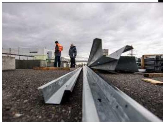
В процесі будівництва буде встановлено 3762 сонячних модуля. Для розміщення технологічного обладнання електростанції використовуються системи кріплення і фундаменти, які були спеціально розроблені з урахуванням вимог майданчику і радіологічної безпеки.
