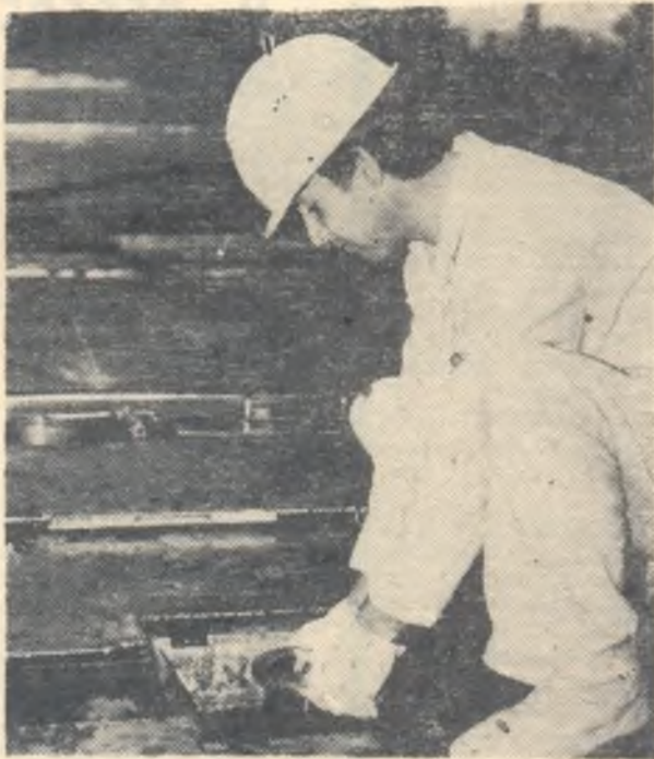
На фото: ремонтные работы на ЧАЭС.
