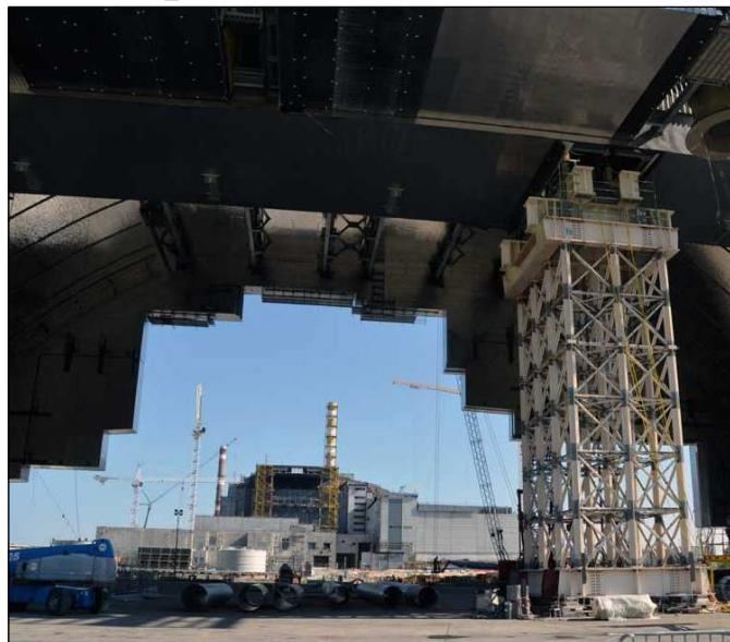
металлических пластин с условным рельсом. Почему условным? В нашем обычном понимании по рельсам передвигаются механизмы, будь то вагоны метро или вагоны трамвая. В нашем случае перемещение Арки осуществляется по пластинам с тефлоновым покрытием. А вертикальная часть металлической пластины (условный рельс) служит для зацепления стопорного устройства размещенного на штоке горизонтального домкрата.
