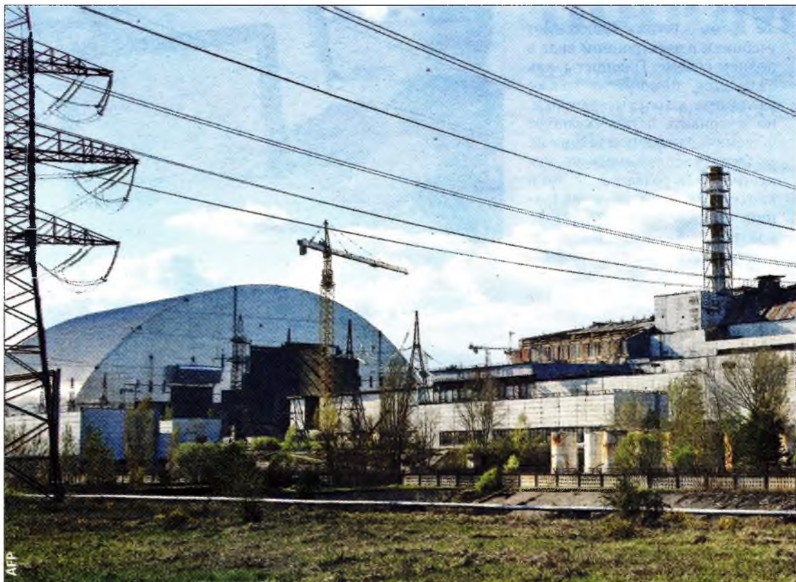
ЧАЭС. Стальная арка будет почти сутки наезжать на взорвавшийся реактор ЧАЭС
