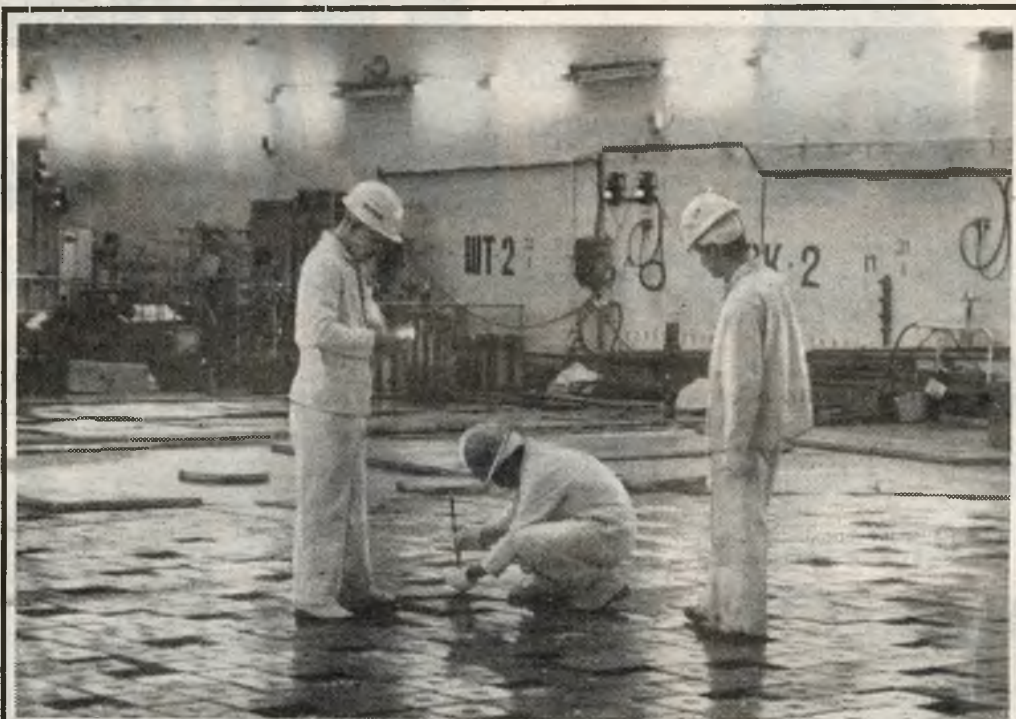
НА СНИМКЕ: на “крышке” реактора энергоблока №3 ЧАЭС. Здесь в технологические камеры опускаются кассеты с ядерным топливом.
