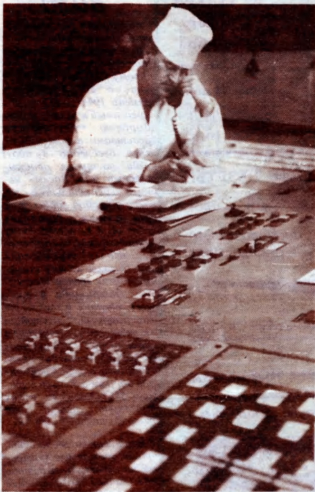
Щит спецводоочистки (блок № 3) ЧАЭС. Фото С. САРАНЫ.
