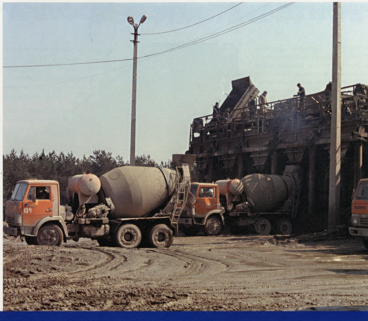
▲ Бетонные заводы были построены в непосредственной близости от строительной площадки "Укрытия". 1986 год
