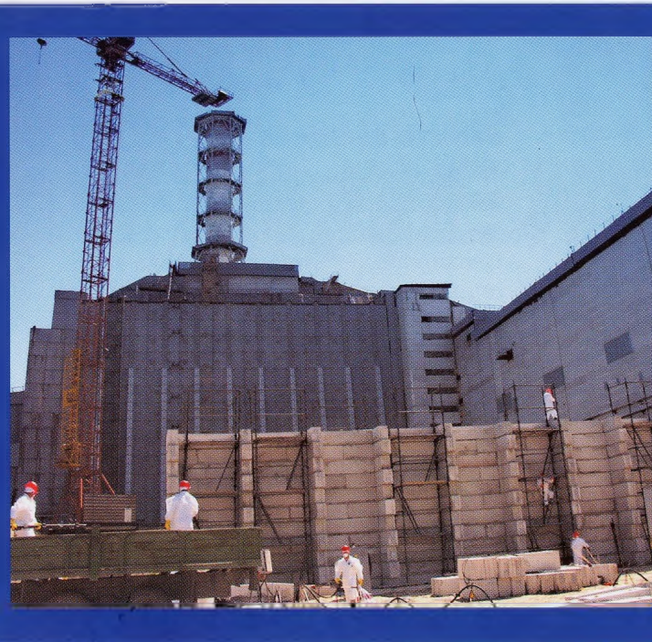
◀ Подготовительные работы к проведению стабилизации западной стены объекта "Укрытие"
