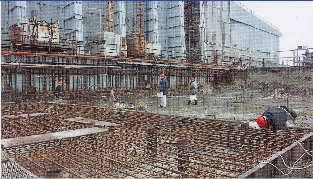
▲ Стабилизационные работы на объекте "Укрытие" в разгаре. Главная задача – обеспечение их безопасного проведения
