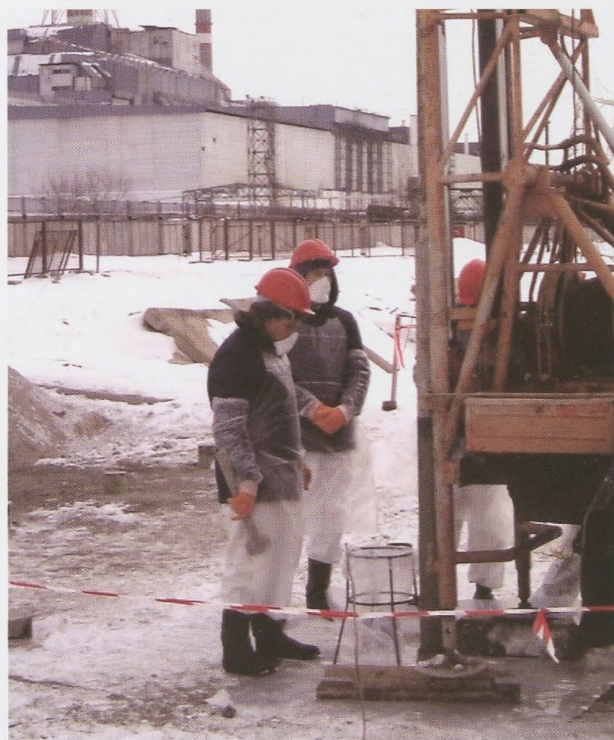
▲ До початку будівельних робіт, відбираються проби зразків ґрунту для перевірки його забрудненості
