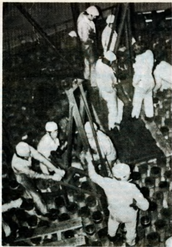
ТАК СТРОИЛАСЬ ЧАЭС.
