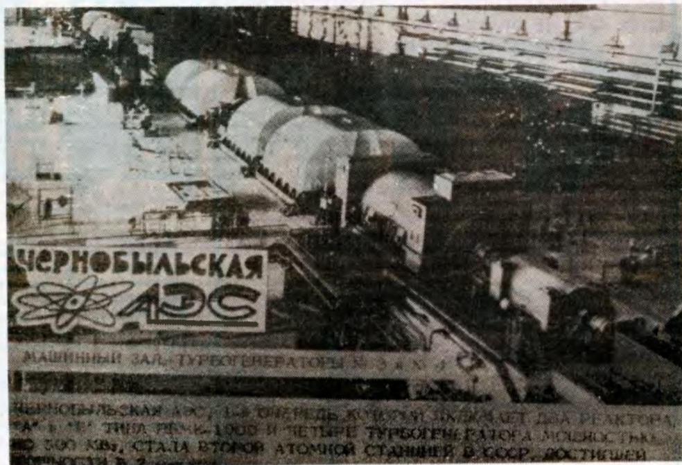
энергетики — Чернобыльская АЭС. Недавно ее посетили зафиксировали более 300 миллионов киловатт-часов, выработанных с начала пуска первого блока. Сейчас ударами темпами ведется монтаж второго блока. «Комсомольское знамя», 6 января 1978 года.
