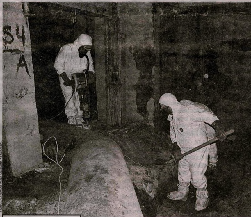
Внутри саркофага. Строители режут старые конструкции и убивают наплывы бетона. На таких работах используют полнолицевую маску с дополнительной защитой от пыли.
