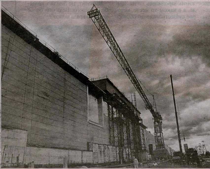
Внутри саркофага. Строители режут старые конструкции и убивают наплывы бетона. На таких работах используют полнолицевую маску с дополнительной защитой от пыли.
