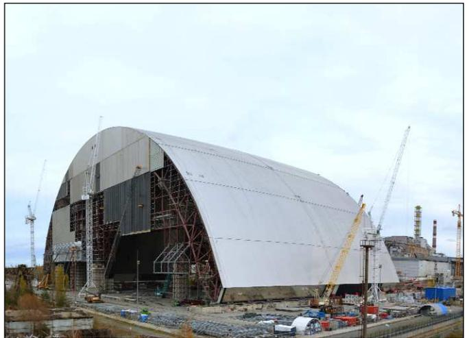
усиления и герметизации существующих конструкций II очереди ЧАЭС. Данный проект обладает критическим взаимодействием со строительством НБК, так как Арка не может быть надвинута в проектное положение и введена в эксплуатацию до завершения строительства торцевых стен.
