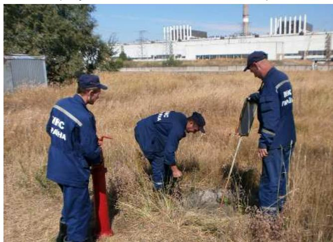
«Чорнобильська АЕС», 2-го Державного пожежно-рятувального загону ГУ ДСНС України у Київській області (м. Чорнобіль) провели перевірку працездатності пожежних гідрантів з пуском води по периметру промислового майданчика ДСП «Чорнобильська АЕС».
