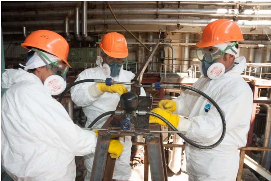
8 июля в машзале блока №4, в районе обрушения кровли и стенных конструкций, начались работы по пылезакреплению на поверхностях обрушившихся конструкций, оборудования, пола и стенных панелей. Работы выполняются персоналом подрядной организации "Буденергомонтаж" в рамках "Плана мероприятий по уменьшению последствий обрушения кровли и снижению потенциальных рисков для существующих конструкций и персонала".
