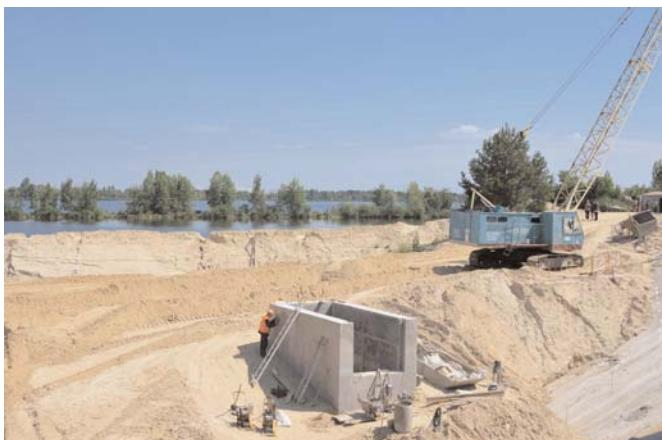
ческом водоеме сооружается водосбросное устройство. Для этого в теле дамбы проложена водоотводная труба и выполняется монолитная железобетонная конструкция, которая будет оборудована шандором и специальными датчиками контроля за уровнем воды и устройством, предназначенным для ее аварийного сброса. То есть, в случае обильных дождей или снегопадов, если уровень воды превысит нормативный - показания с датчиков будут передаваться начальнику смены ПОК.
