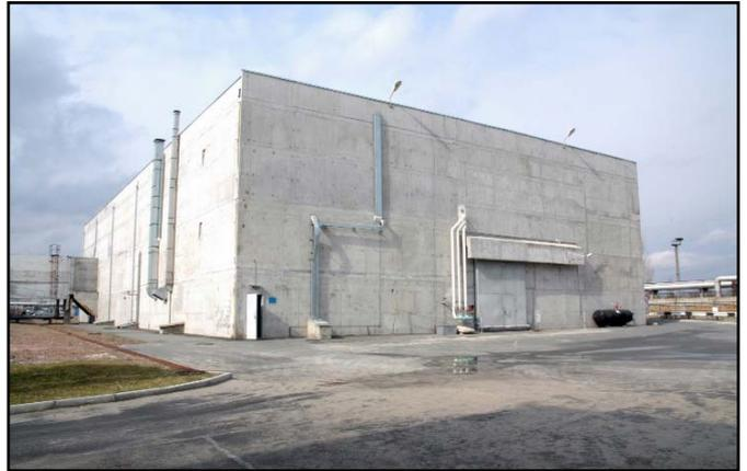
образовываться в результате работ по снятию ГСП ЧАЭС с эксплуатации и преобразования объекта «Укрытие» в экологически безопасную систему. Проектная производительность завода составляет 42 упаковки РАО в сутки (цементированные ЖРО в 200-литровой бочке). В 2006 году Контракт на строительство ЗПЖРО «под ключ» с Консорциумом компаний BELGATOM\SGN\ANSALDO был расторгнут, управление проектом ЗПЖРО в полном объеме взяло на себя ГСП ЧАЭС.
