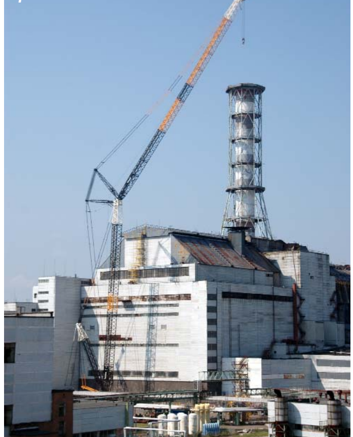
Кран для монтажа НВТ
