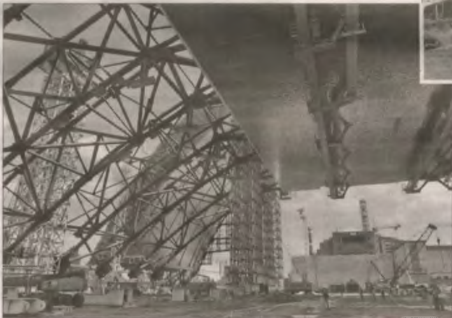
Травень 2014 р. Будівництво західної частини нового безпечного конфайнменту.
