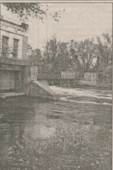
Восстановленная Седневская ГЭС подняла уровень реки на 2,5 метра
