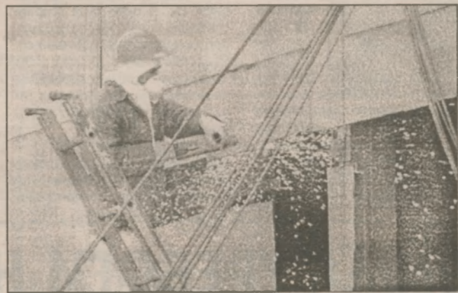
Стабилизационные работы на кровле "Укрытия"
