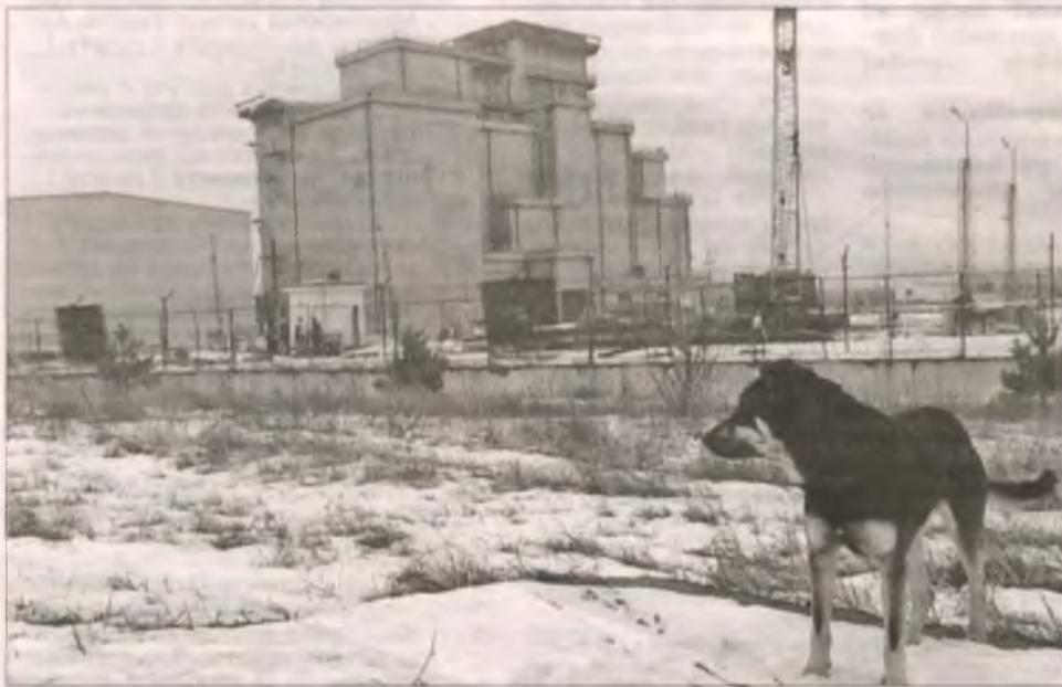
Триває будівництво сховища відпрацьованого ядерного палива сухого типу (СВЯП-2).
