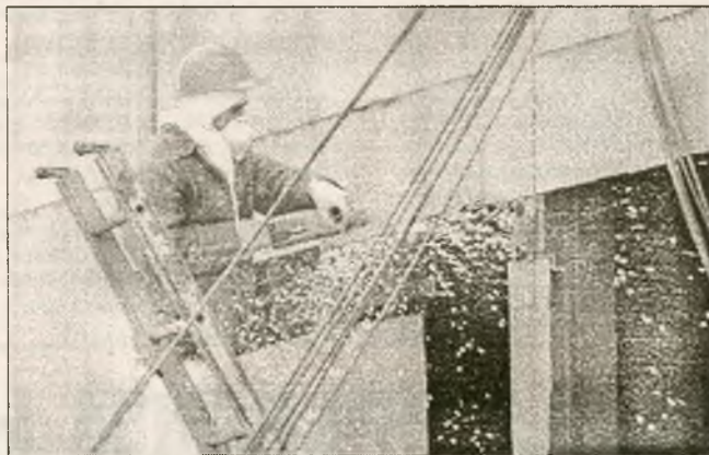
Стабилизационные работы на кровле "Укрытия"
