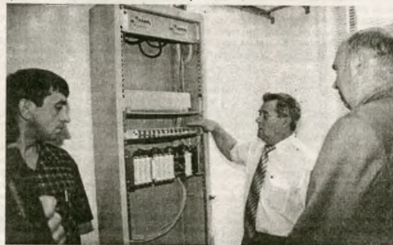
Члены государственной и рабочей комиссий крайне придирчиво осмотрели колодцы, в которые введена оптоволоконная линия и распределительный пункт, оборудованный в здании гортелекома
