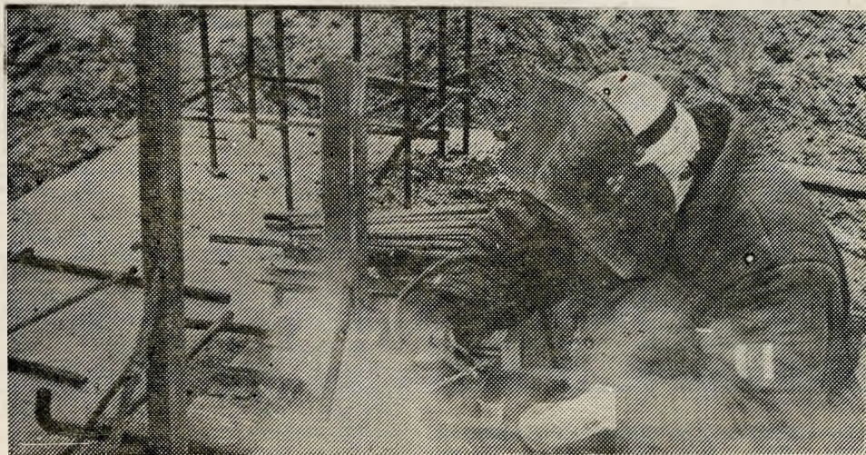
Строительные работы на котельной для обслуживания ЧАЭС. Фото В. САВРАНА.
