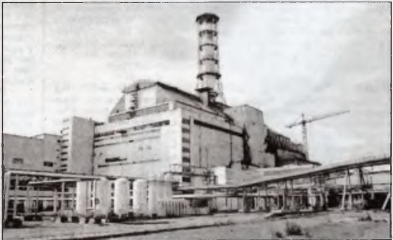
● Так виглядає четвертий блок сьогодні, майже повністю зруйнований всередині тим зловісним вибухом у 1986-му.
