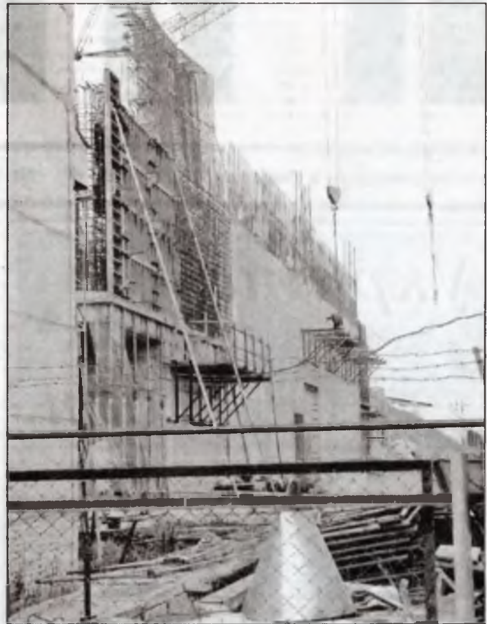
● На величезному будівельному майданчику поряд зі станцією повним ходом іде будівництво заводу з переробки рідкого ядерного палива.
