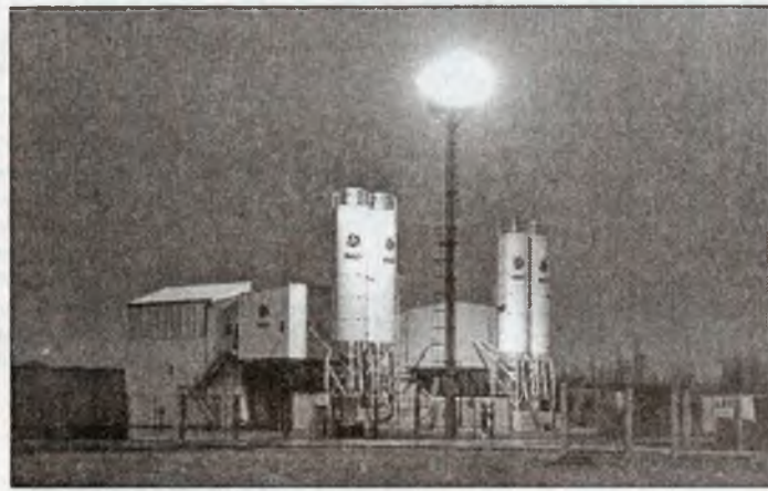
Ні на годину не припиняє роботу бетонний завод.
