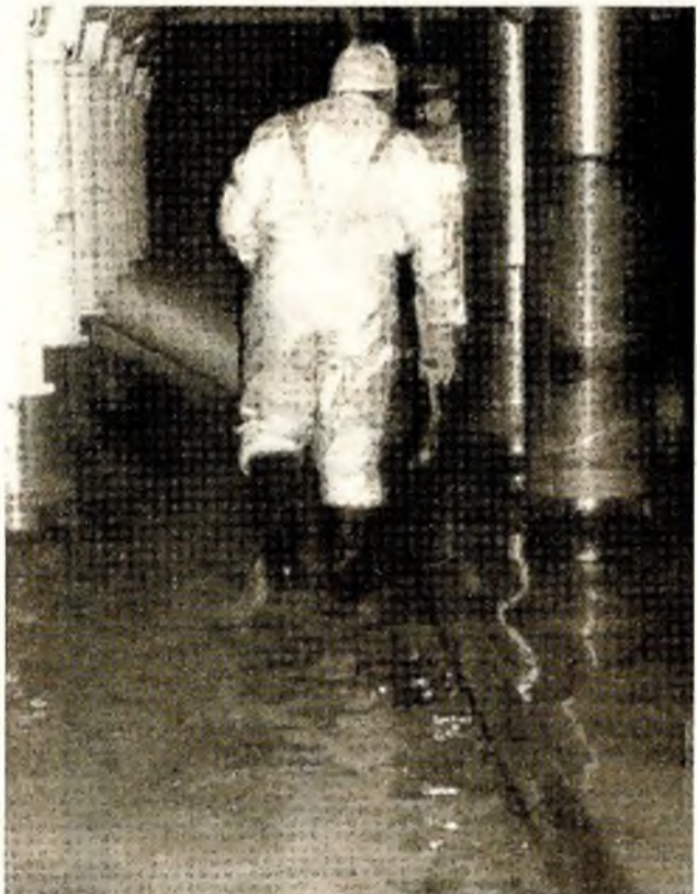
Вода в приміщеннях на нижніх відмітках
