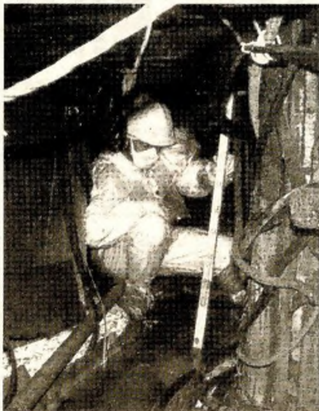
Обстеження приміщень "Укриття"
