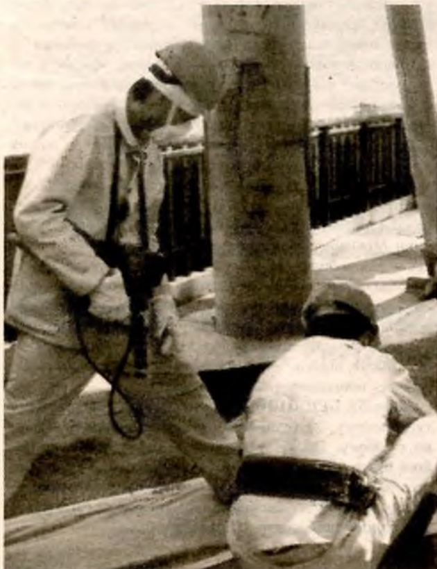
Вентиляційна труба 3 та 4 блоків. Ремонтні роботи
